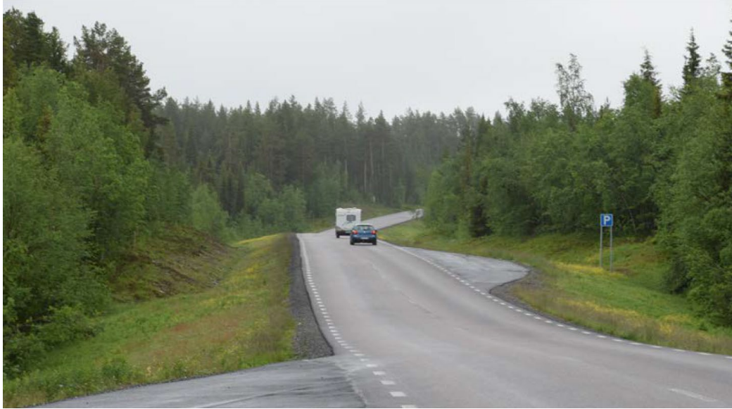
Figur 2. Vy över befintligt vägrum med flacka grästäckta innerslänter där befintlig vegetation ansluter i bakslänts släntkrön. Befintlig plan och profil bidrar till att upplevelsen av vägrummet delas upp i sektioner för trafikanten och stundtals begränsar sikten.
