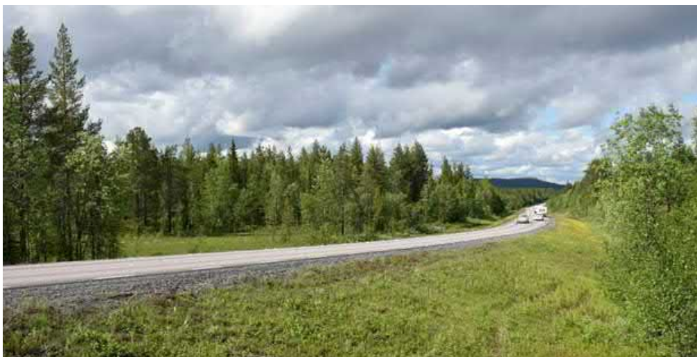
Figur 3. Längs med stor del av sträckan växer vegetation ända fram till väggkanten vilket bidrar till att förstärka väggrummets väggar.
