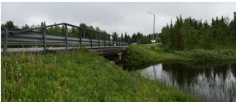
Figur 22. Befintlig vägbro över vattendraget Kivijoki vid Kivijärvis utlopp vid Moskojärvi. Vy norrifrån över den västra sidan som föreslås breddas.
