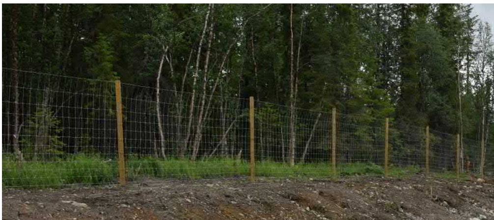
Figur 28. Viltstängsel med trädstolpar, placerat i anslutning till ny faunabro vid Svappavaara, norr om vägområdet.
