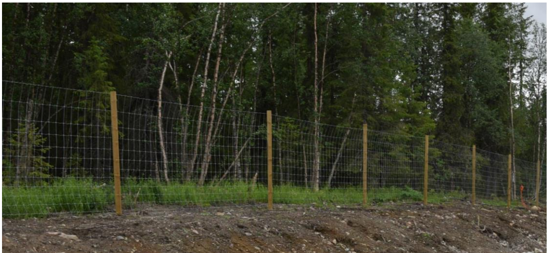
Figur 33. Viltstängsel med trädstolpar, placerat i anslutning till ny faunabro vid Svappavaara, norr om vägområdet.
