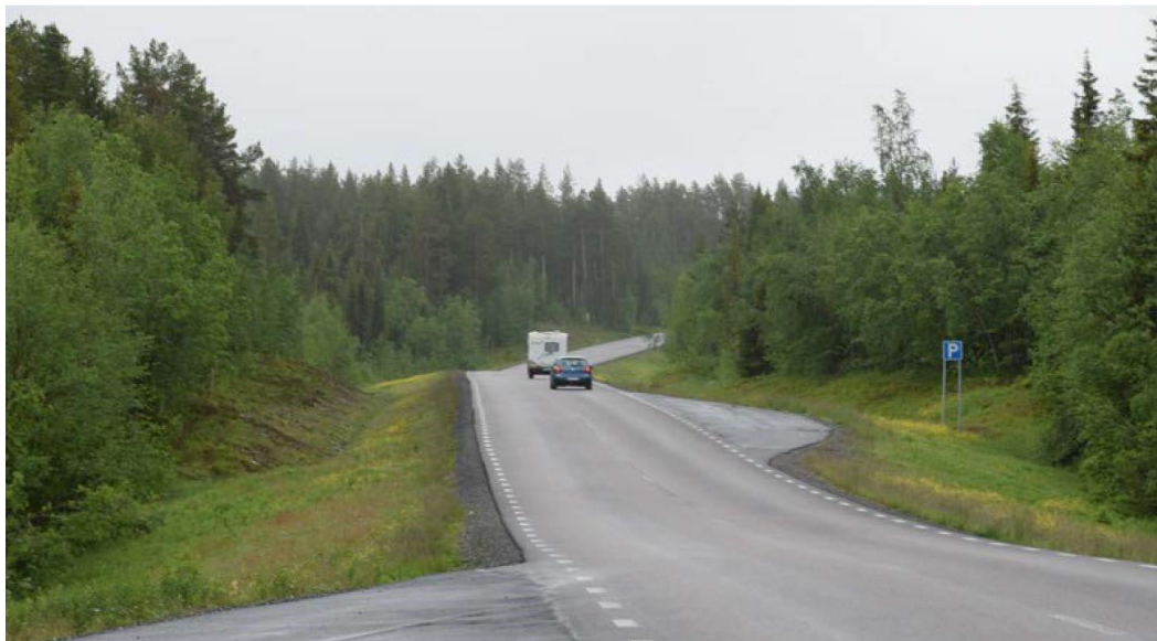
Figur 2. Vy över befintligt vägrum med flacka grästäckta innerslänter där befintlig vegetation ansluter i bakslänts släntröner. Befintlig plan och profil bidrar till att upplevelsen av vägrummet delas upp i sektioner för trafikanten och stundtals begränsar sikten.
