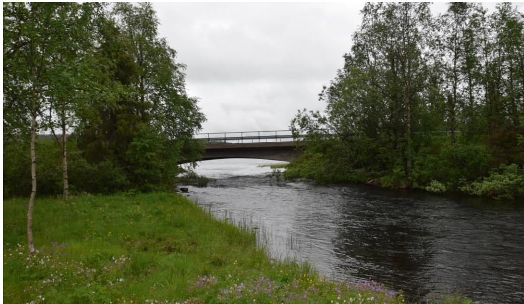
Figur 4. Den nya gång- och cykelbron planeras att ligga strax nedströms befintlig vägbro som syns i bilden.
