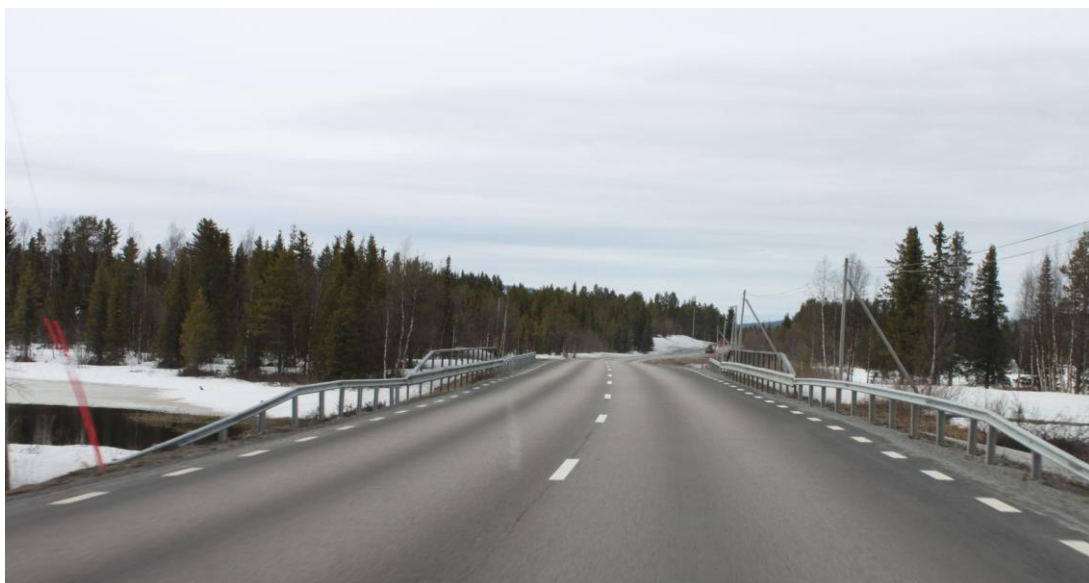
Figur 3. Befintlig bro över Kivijoki är en 9 meter bred plattrambro i betong (Foto Trafikverket)
