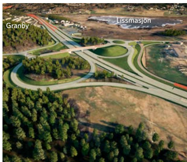
Vy mot trafikplats Lissma sett från sydöst..
