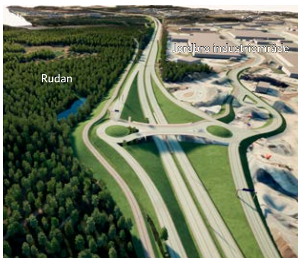
Vy mot trafikplats Rudan sett från väster.
