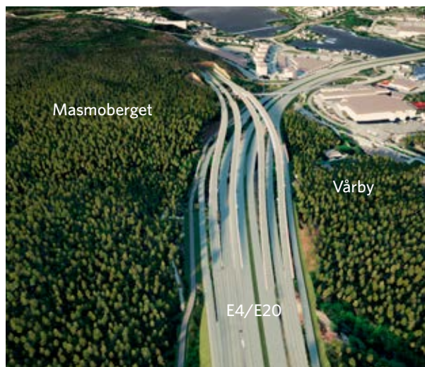
Vy mot trafikplats Gömmaren sett från norr..
