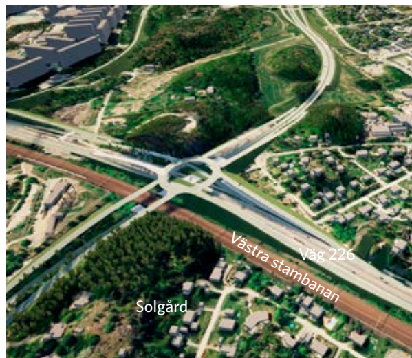
Vy mot trafikplats Solgård sett från nordöst.
