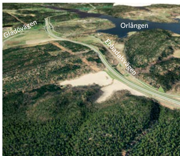
Vy mot tvärförbindelsen vid Gladö trafikplats sett från söder.
