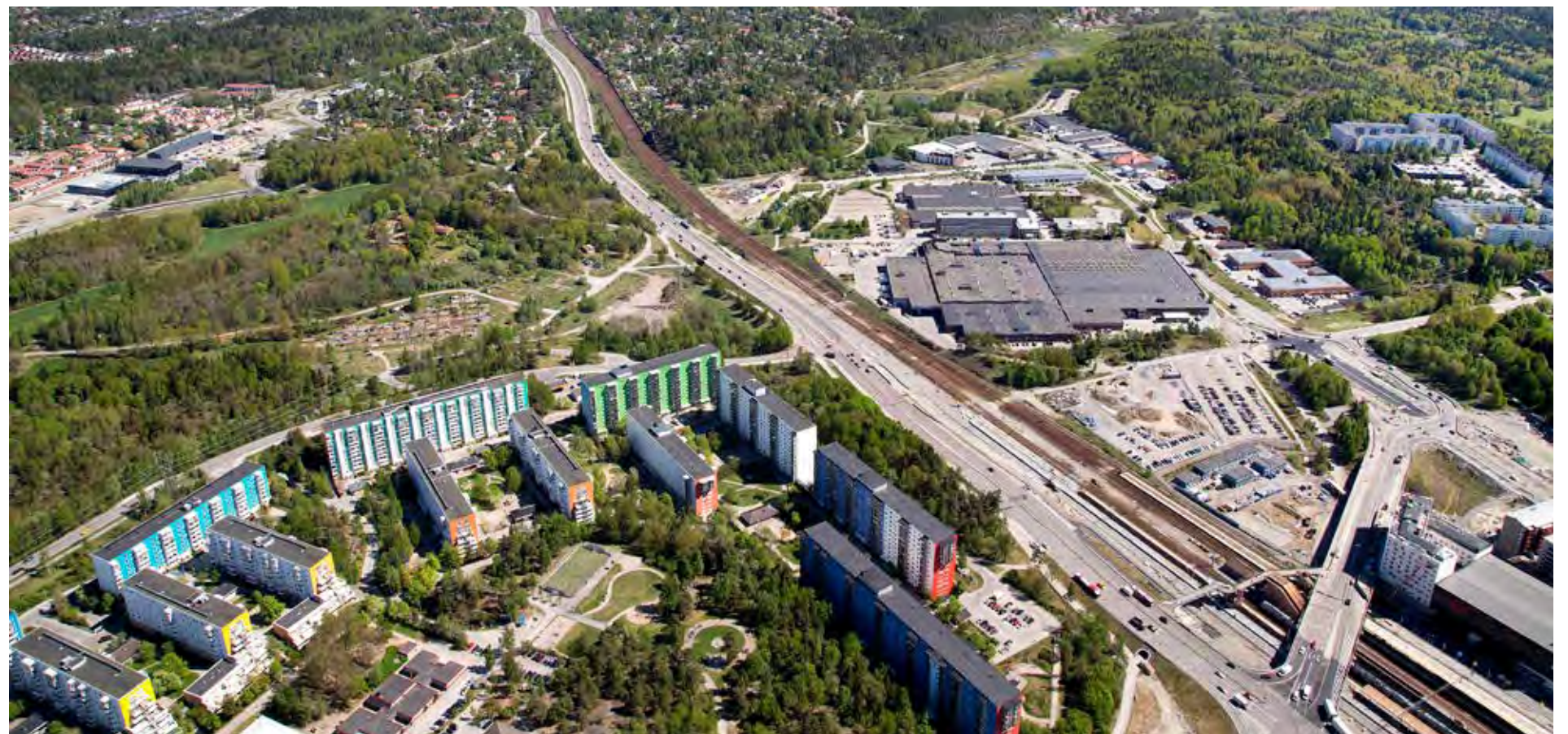
Vy över Grantorp, Huddingevägen och Västra stambanan. Flemingsberg präglas starkt av infrastrukturen kring Huddingevägen och Västra stambanan samt anslutande verksamhetsområde med en stor andel hårdgjord mark. Miljonprogramsområdet Grantorp är tidstypiskt planerat med genomtänkt trafikseparering och direkt koppling ut till naturen. Omgivningen kring Flemingsbergs gård med kolonilotter är viktig för närrekreation. Foto: Hans Ekestang-Trafikverket
