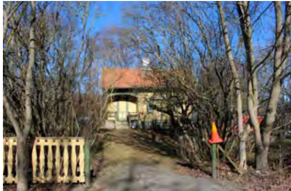
Vattenvaktarbostaden på näset som tillkom med huvudvattenledningen 1904.
