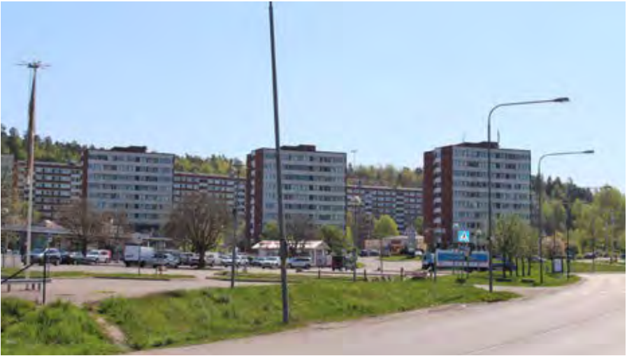
Bostadsområdet Masmö i stram 60-tals modernism med rytmiskt placerade punkthus framför den svängda lamellen Ormen Långe vars böljande form följer bakomvarande förkastningsbrant.
