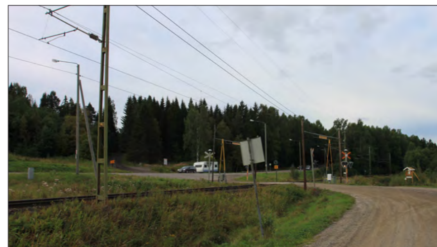
Plankorsning för Mittbanan i nära anslutning till E14.
