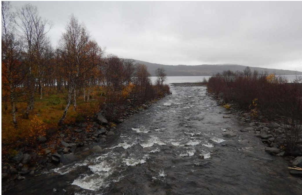
Figur 11. Från bron på väg 662 över Husån, mot Kallsjön.
