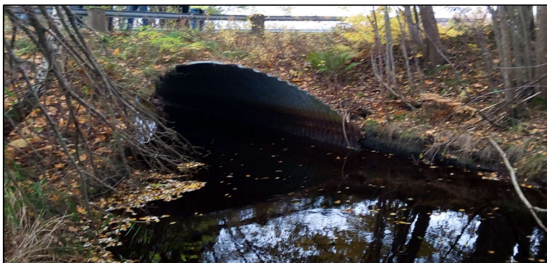
Figur 62. Rörbro som leder Borån under befintlig väg väster om väg 27 i den södra delen av projektet.
