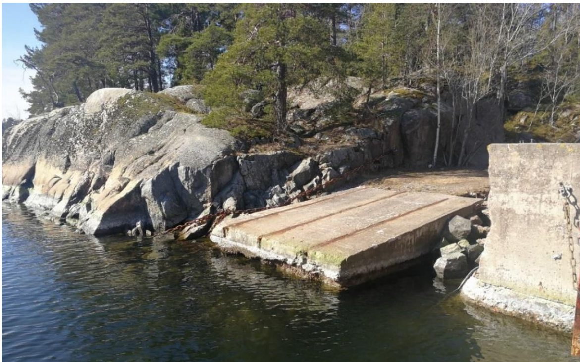
Figur 10. Larshamns reservfärjeläge med berghällar. Sett från öster.
