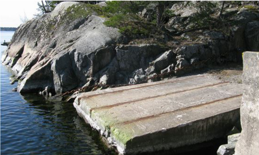
Bild 14. Befintligt berg vid Larshamn som kommer att påverkas av planerad bergschakt.
