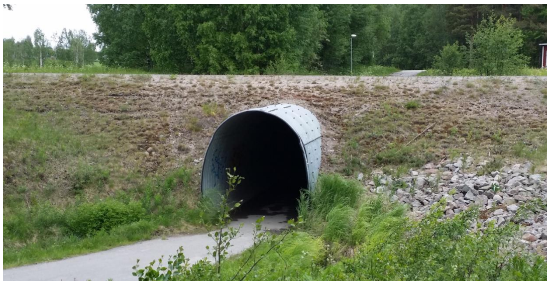
Figur 7 – Gång- och cykelport under väg 373.
