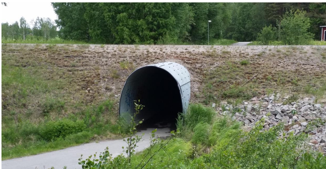
Figur 7 – Gång- och cykelport under väg 373.
