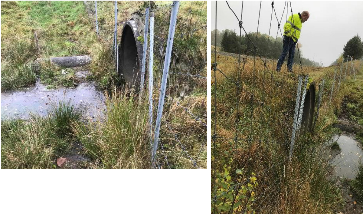
Figur 34 Trumma och möjlig djurpassage ca 570 meter väster om Krokån, vid Slättevå/ Björkelund. Ett småvatten i jordbrukslandskap.
