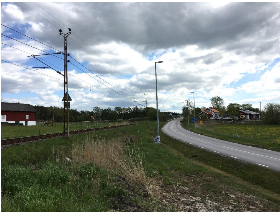
Figur 17. Vy från norr (område A1) mot den befintliga bron intill bebyggelsen på den äldre bytomten (B1).
