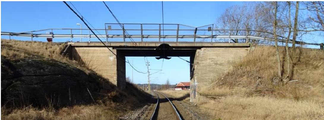
Figur 20. Vy, Befintlig bro över järnväg vid Gunnesby.
