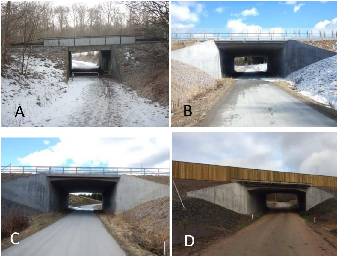
Figur 31. Befintliga passager som bedöms kunna fungera för stora däggdjur. Port A längst upp till vänster, port B (öster om Hörby) längst upp till höger, port C (mellan trafikplatserna Ekeröd och Linderöd) längst ner till vänster samt faunapassagen söder om Linderöd längst ner till höger (D). (Trafikverket, Batman 2023)
