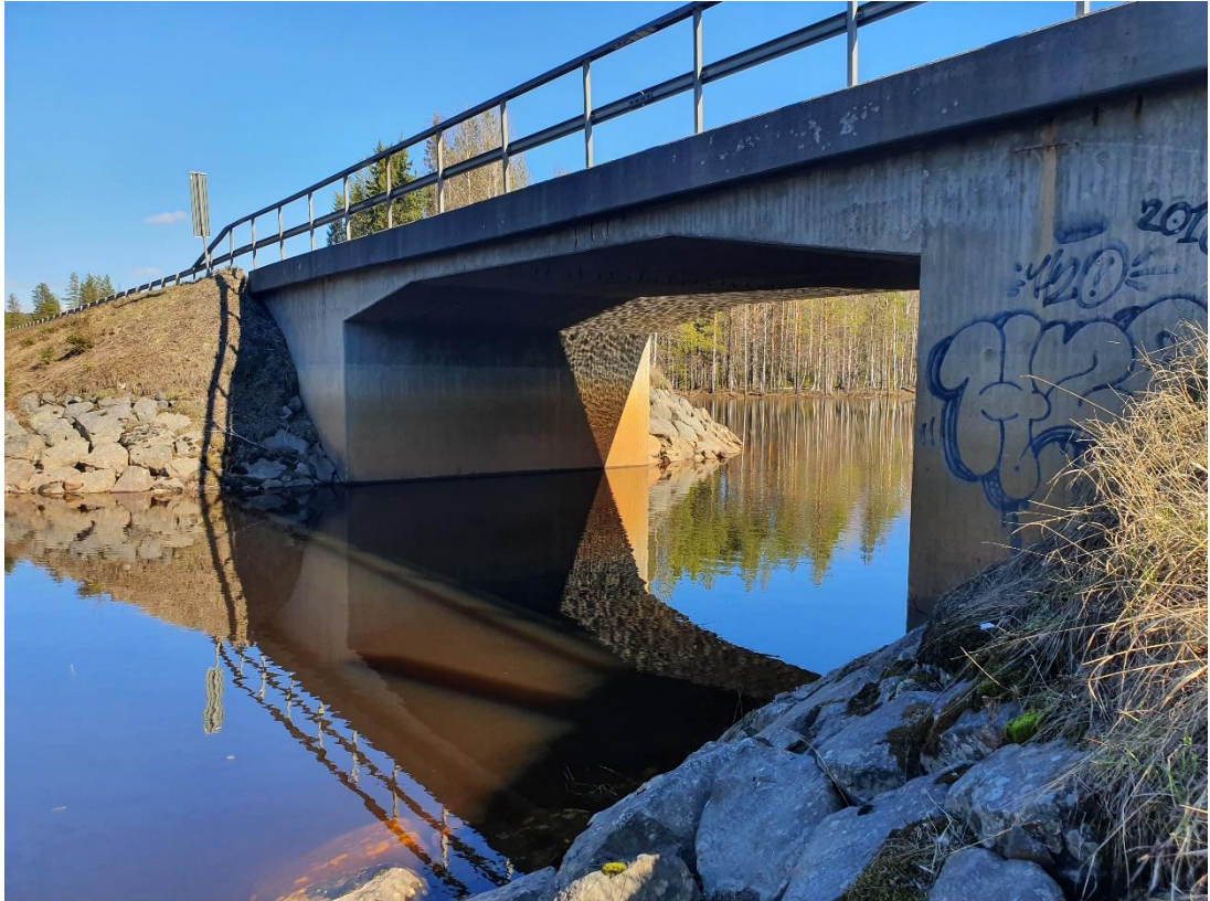
Figur 1. Befintlig bro över Kälván.
