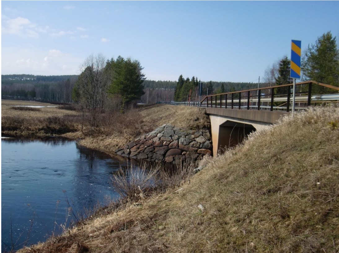
Figur 1. Befintlig bro över Grundträskån.
