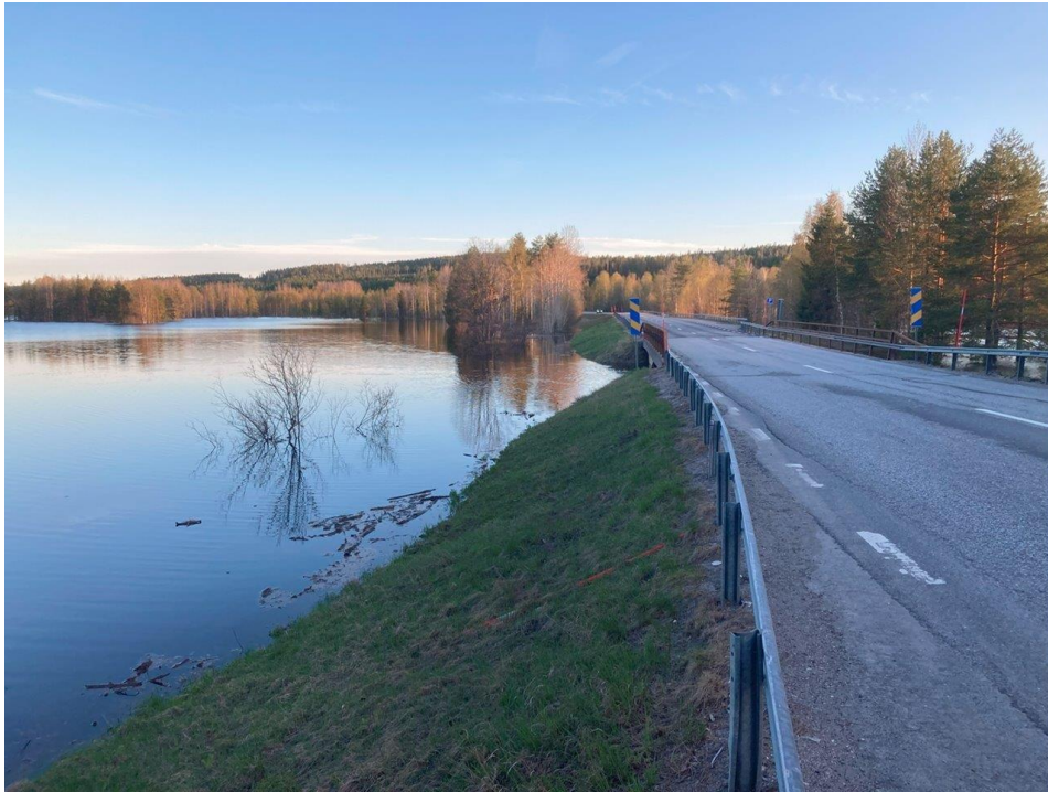
Figur 6. Grundträskån öster om E10. Fotot är taget i sydlig riktning. Området öster om vägen är översvämmat.
