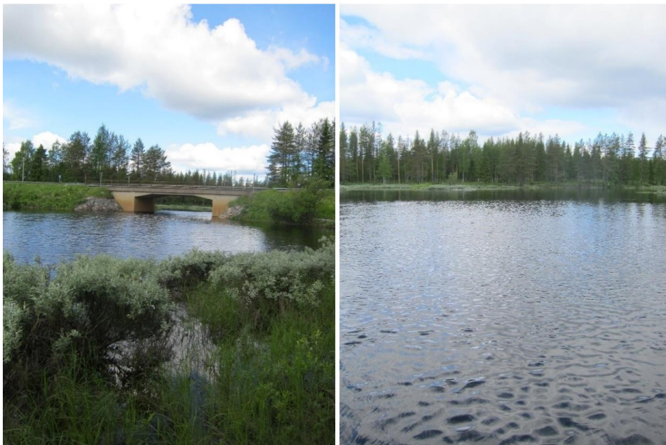
Figur 11. Grundträskån öster om E10 med vägbron i bakgrunden (vänster bild). Grundträskån uppströms vägbron (höger bild) (Källa: Trv 2019).
