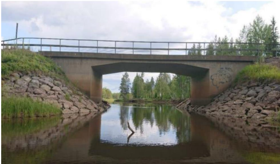
Figur 3. Befintlig bro över Grundträskån.
