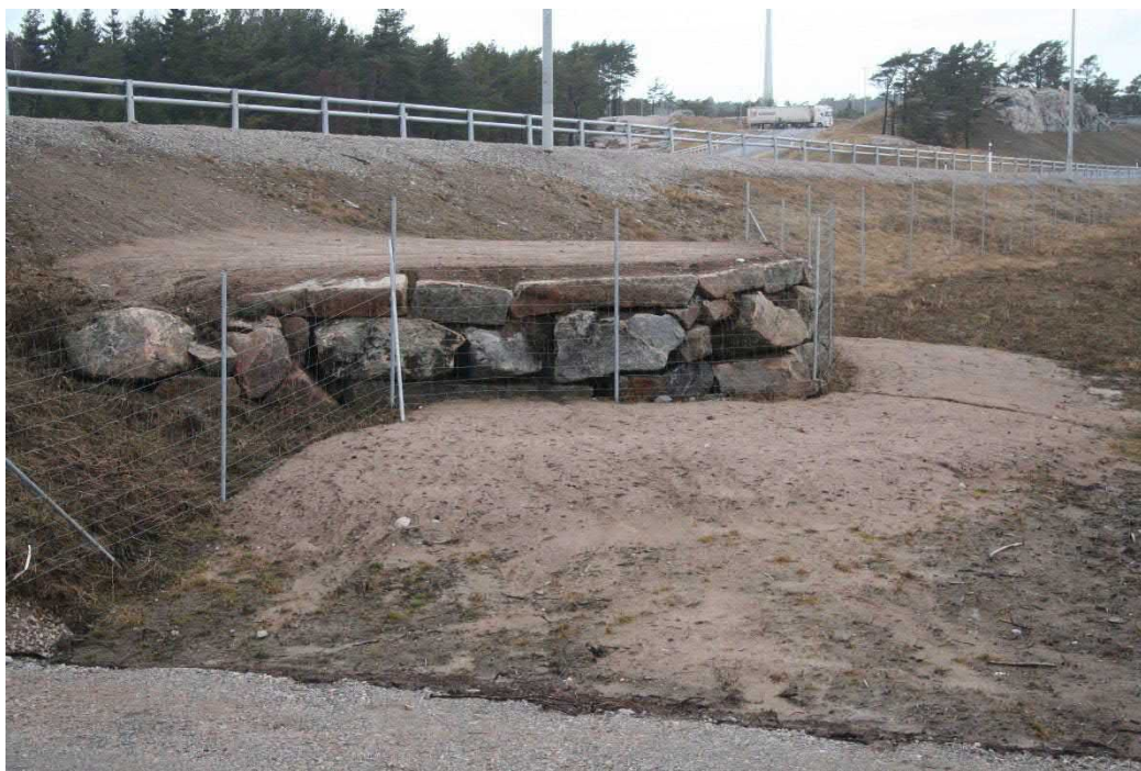
Figur 2. Uthopp kan anläggas som en ramp och ha viltstängsel som skydd mot att djur hoppar in vid stora snömängder. Foto: Mattias Olsson, E6 vid Lugnet
