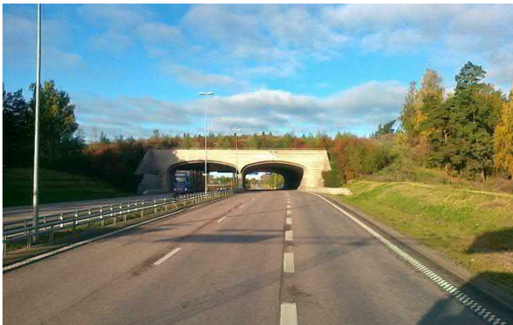
Figur 4. Exempel på ekodukt, denna över Bärbyleden i Uppsala (foto från BatMan).
