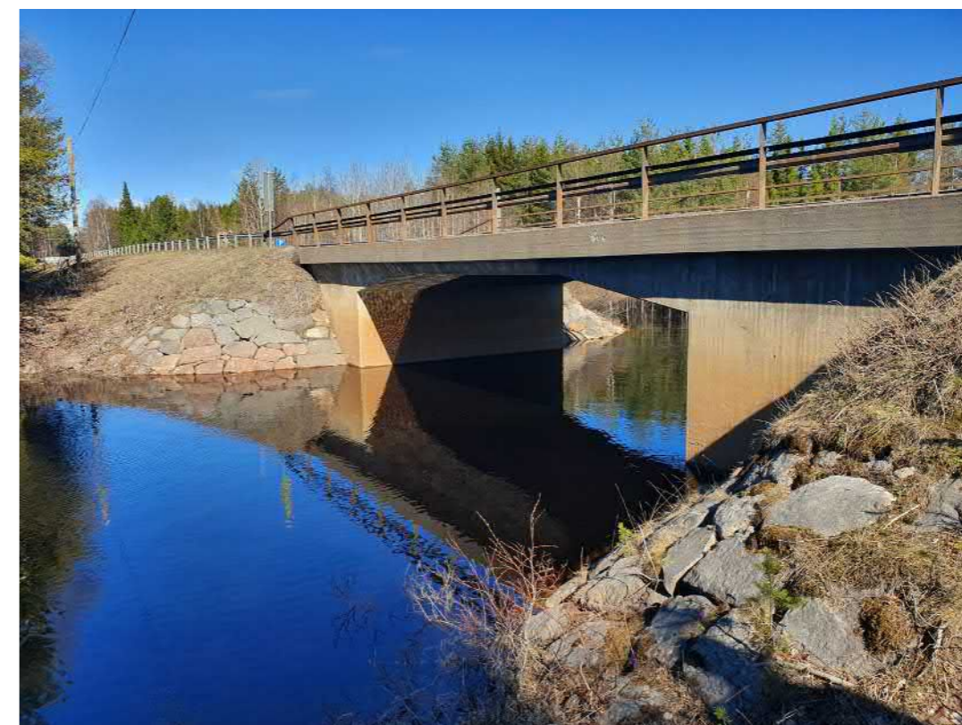
Bild 5.2.4-3. Befintlig bro över Grundträskån med raka vingmurar och erosionsskydd av sten.
