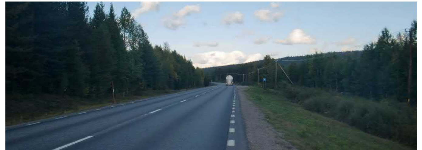
Bild 3.1-3 Brett vägrum vid ledningsgata.
