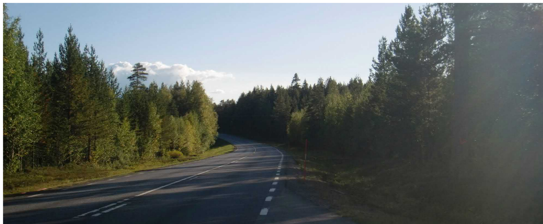
Bild 3.5-2. Vägen kantas av skogsmark och följer terrängens former.
