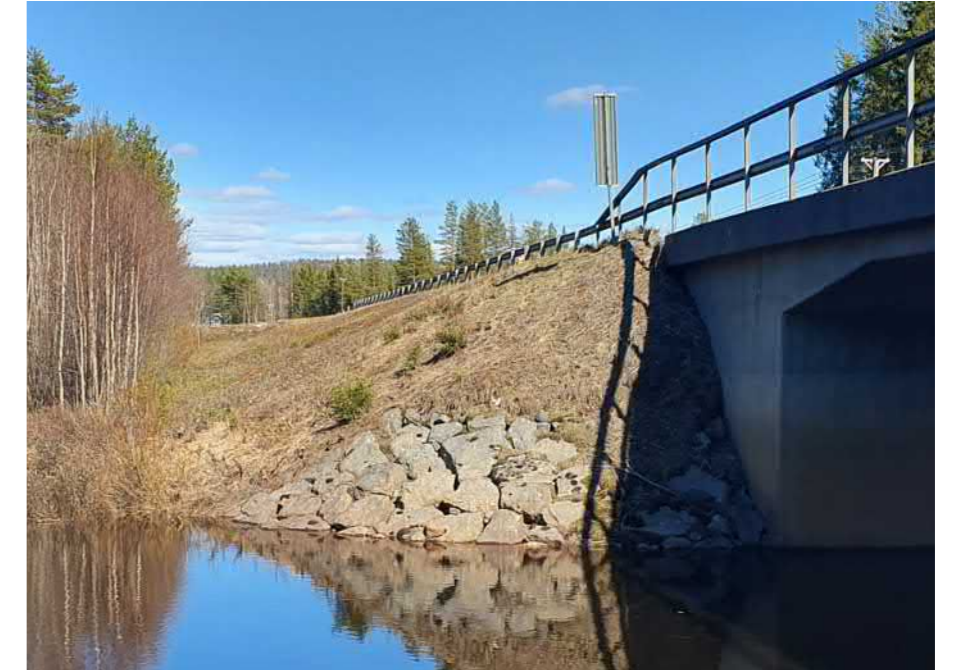
Bild 5.2.4-7. Befintlig bro över Kälvån med raka vingmurar och erosionsskydd av sten.
