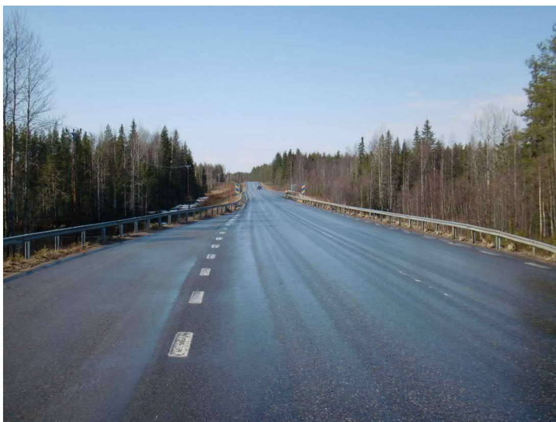
Figur 16. Foto taget längs vägen på södra sidan Kälvån, vy mot befintlig bro.
