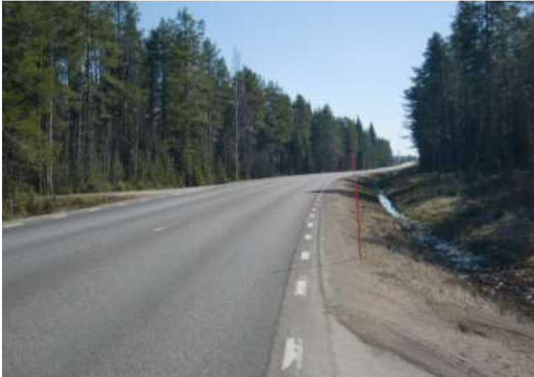
Figur 2. Bristfällig sikt försvårar omkörningsmöjligheterna och begränsar framkomligheten.
