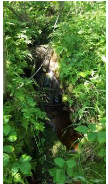
Figur 14 och 15. Trumman vid lomtjärnsbäcken har delat sig och vattnet rinner ner i trumbädden, under trumman (fig. 14). Uppströms kommer bäcken från Lomstjärnen via flera fallsträckor (fig. 15).
