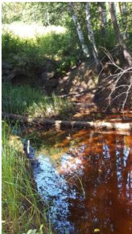
Figur 42. Bilden visar utloppet från trumman nedströms väg E 10.
