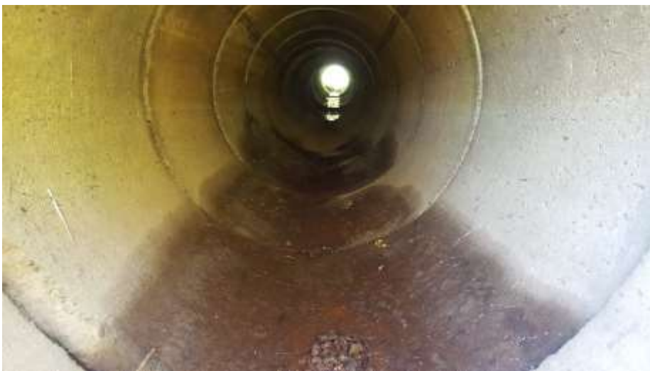
Figur 14 och 15. Trumman vid lomtjärnsbäcken har delat sig och vattnet rinner ner i trumbädden, under trumman (fig. 14). Uppströms kommer bäcken från Lomstjärnen via flera fallsträckor (fig. 15).
