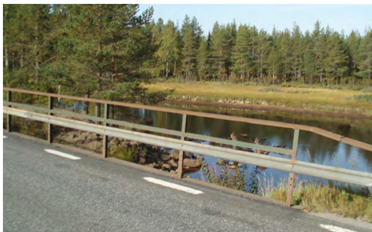
Figur 12. Bron över Grundträskån har delvis kvar de ursprungliga räcken. Navföljaren är utbytt.
