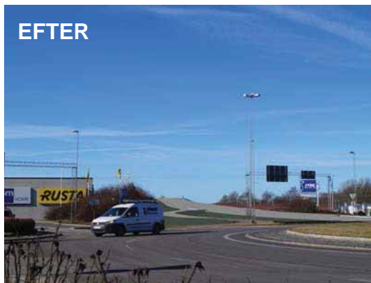
Figur 7.31 Vy mot Getteröbron från cirkulation vid väg 41 före och efter ombyggnad.
