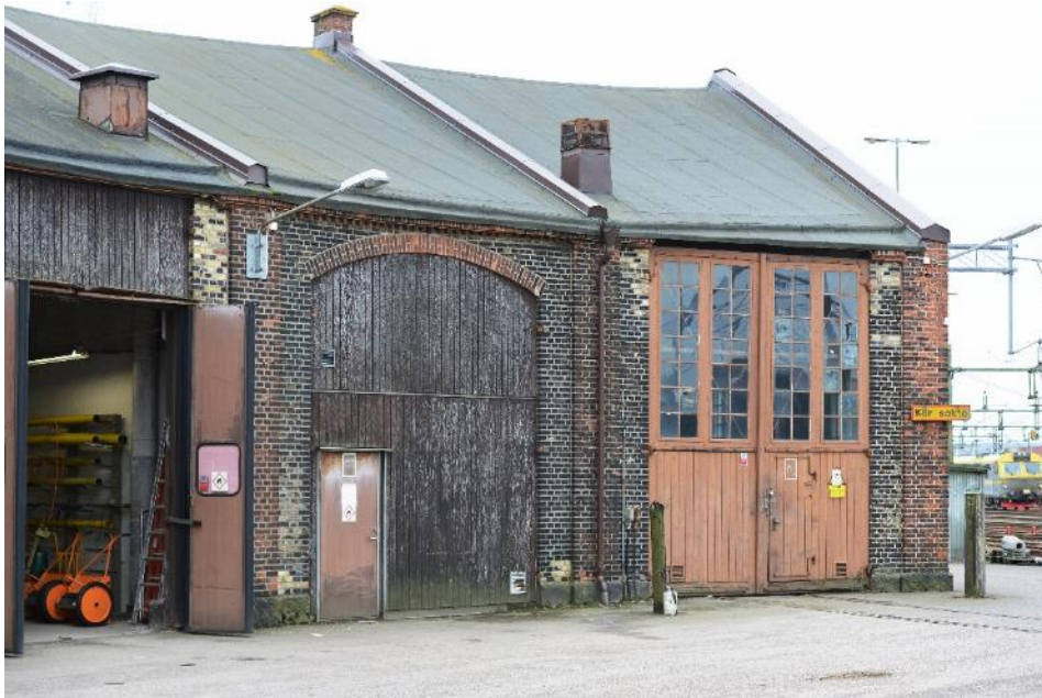
Figur 37 Södra delen av lokstallarna.
