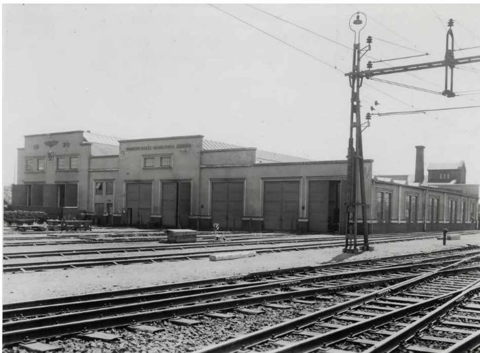
Figur 7 Lokverkstaden efter utbyggnaden 1930 (vm.KDAA15214).
