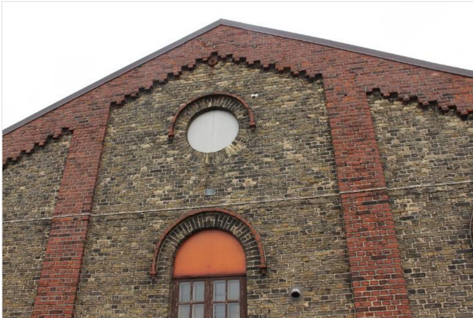
Figur 17 Gavelnsida har getts särskild omsorg vid utformningen. Fasaden delas in av fyra lisenor i rött tegel, mot en fasad av gult tegel. Lisenernas röda tegel fortsätter sedan i en bred trappstegsformad list, som följer gaveln.
