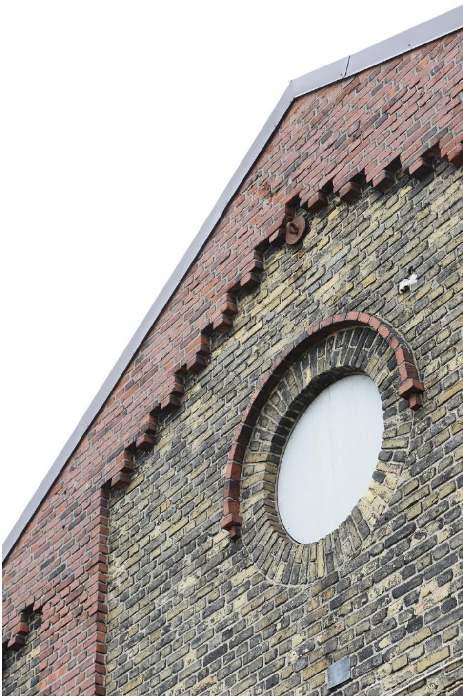
Figur 38 Detalj av den södra gaveln mot spårområdet.
