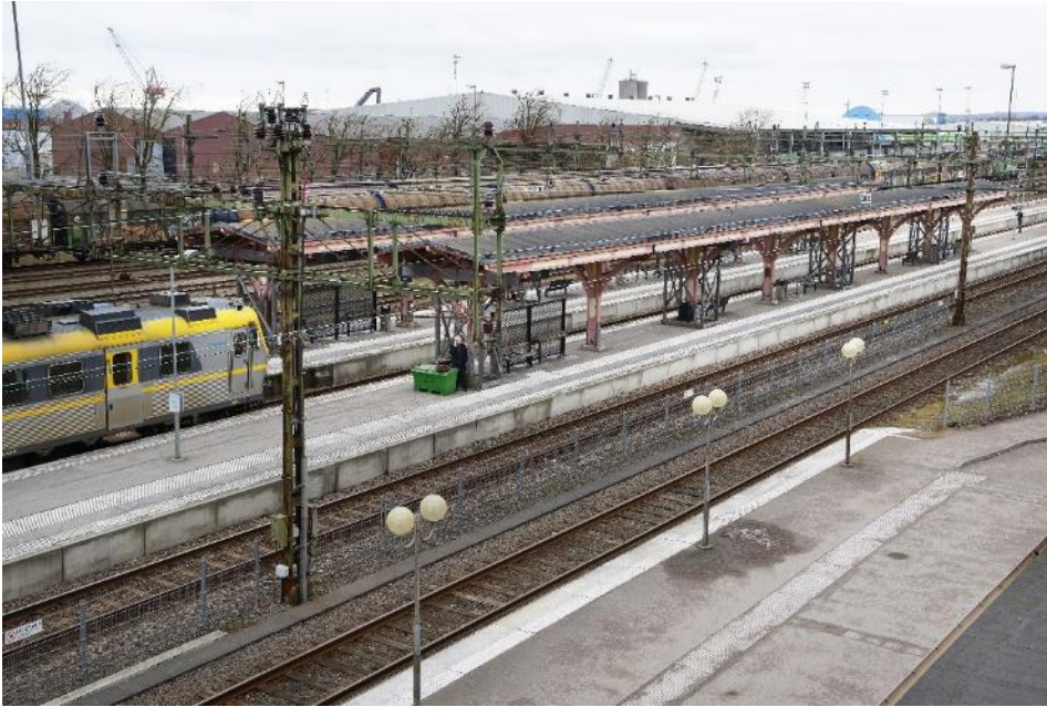
Figur 29 De båda plattformstaken sedda från sydöst.
