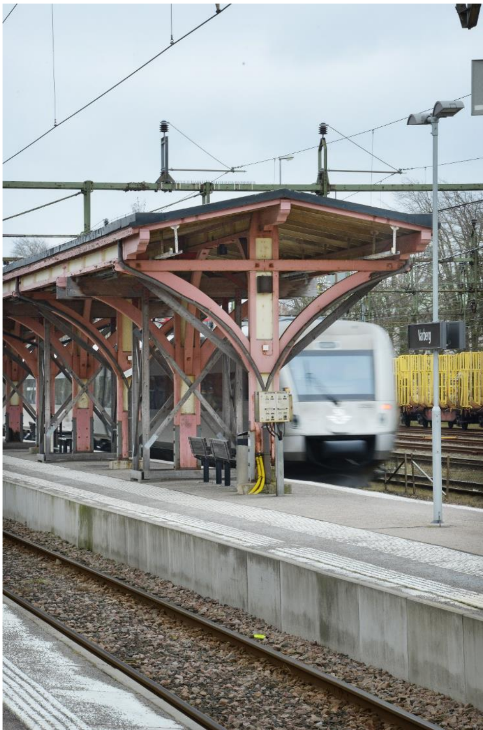
Figur 32 Plattformstaken hålls upp av stöttor.
