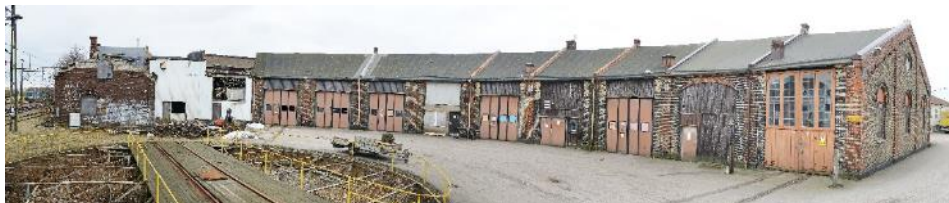
Figur 15 Lokstallet består av ett antal tårtritsformade sektioner med portar in mot den centrala gården. Från sektionerna har tidigare gått spår fram till vändskivan
