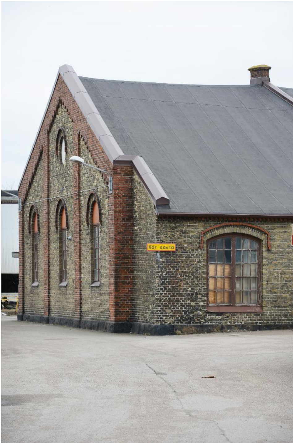
Figur 50 Del av lokstallarna från söder.
