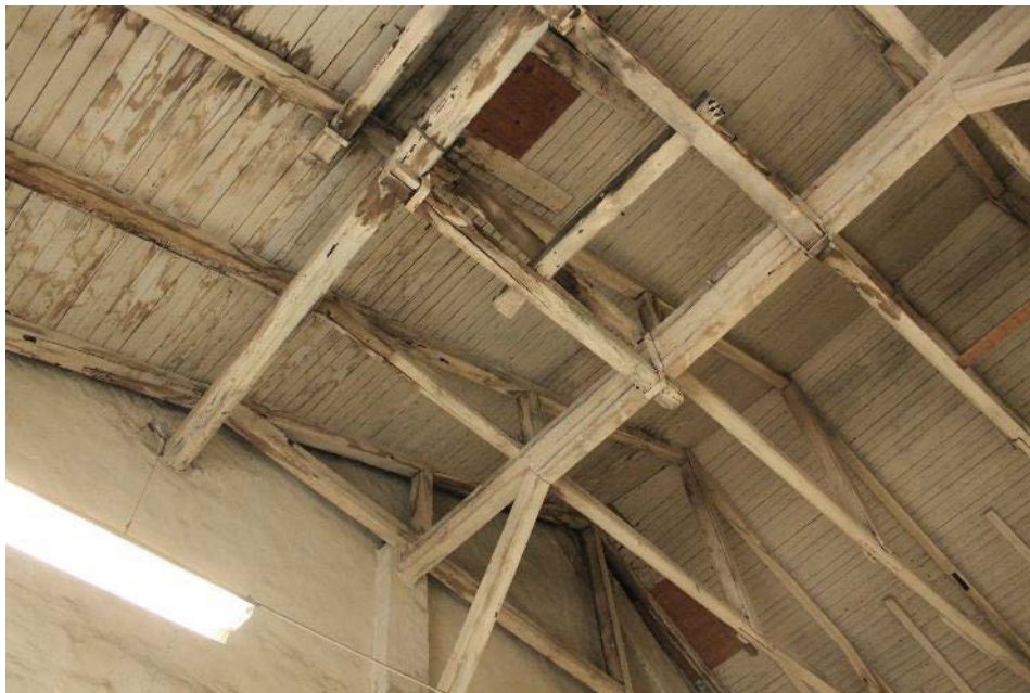
Figur 22 Synliga takstolar i den äldre delen av lokstallarna.
