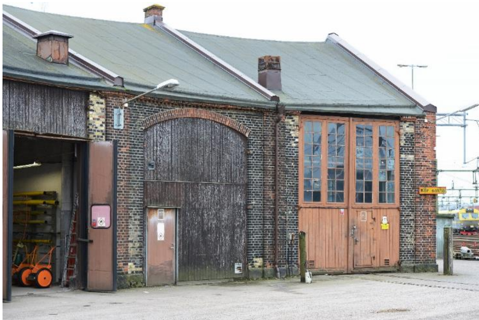
Figur 16 Närmast gaveln sitter äldre träportar med glasad rak överdel. De påminner om de ursprungliga dörrarna, men är senare tillkomna. Ursprungligen hade portarna en svagt rundad överdel. En stickbåge i tegel finns fortfarande kvar över öppningen närmast intill.
