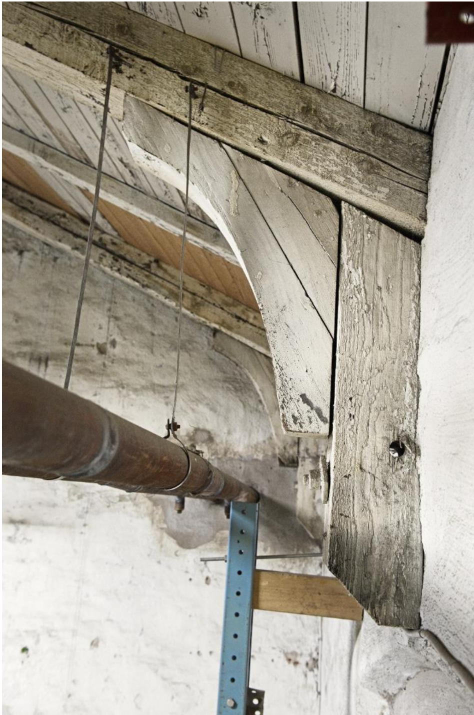
Figur 48 Lokstallarna. Detalj av innertak.
