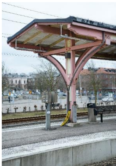
Figur 11 Norra änden av det östra plattformstaket.
