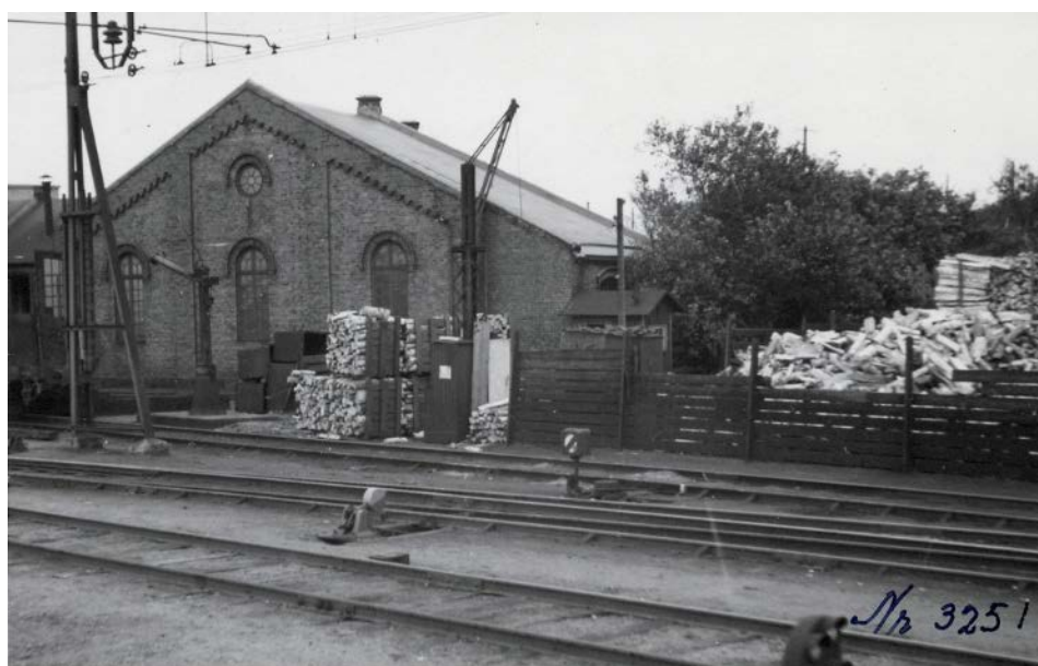
Figur 4 Lokstallarna i Varberg. Notera vattenkastaren intill gavelfasaden på lokstallarna (Jm.KDAE07465).
