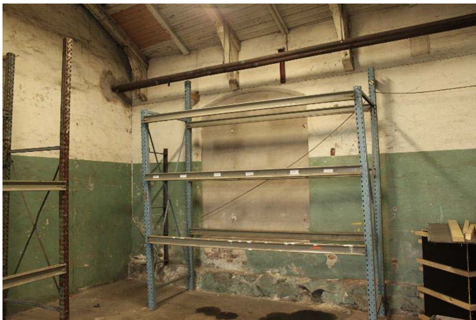
Figur 23 Lokstall i den äldre delen av byggnaden. Notera färgsättningen av väggen.
