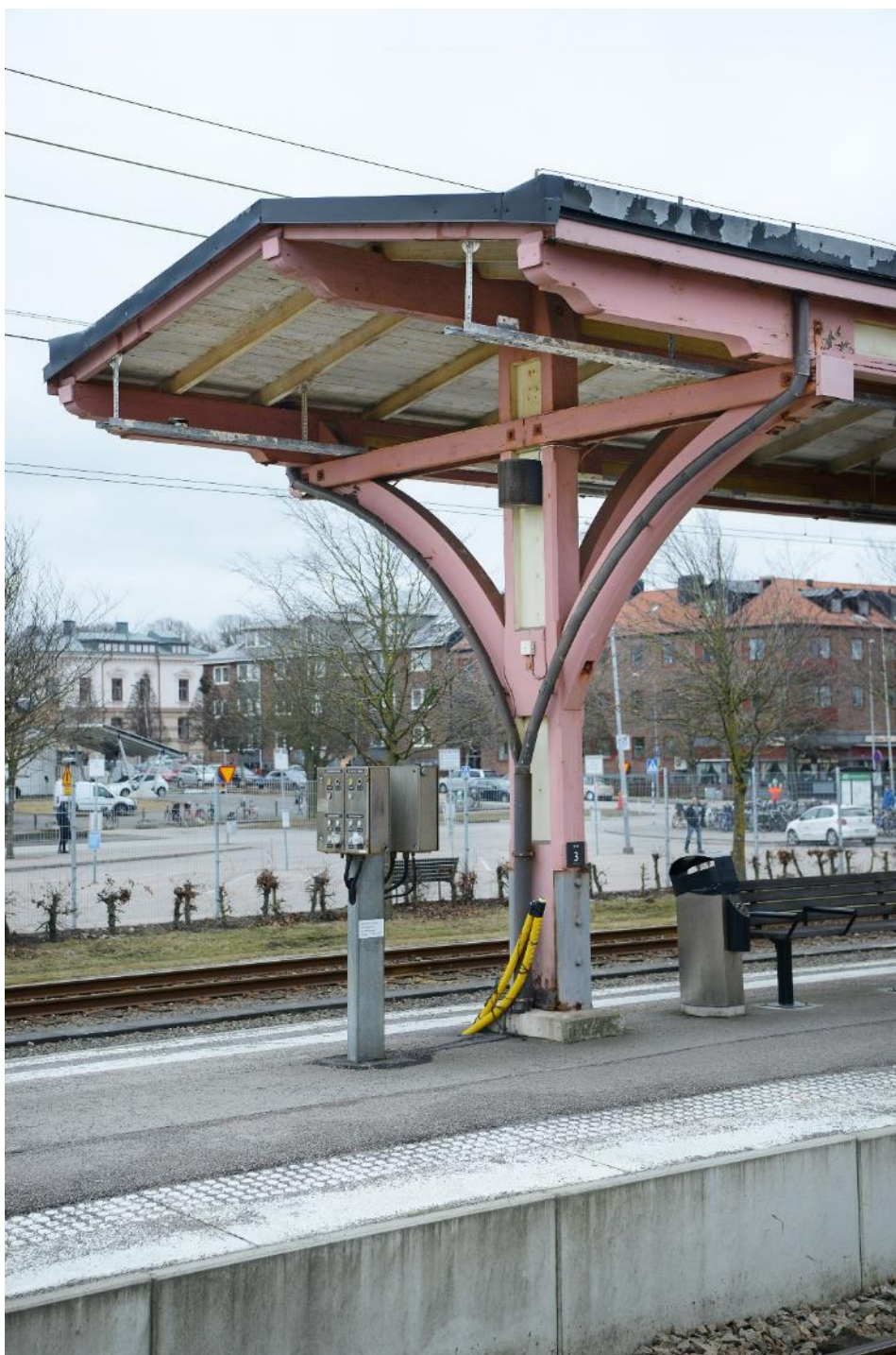
Figur 31 Norra änden av det östra plattformstaket.
