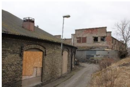
Figur 19 Igensatta fönsteröppningar på baksidan av lokstallarna. I bakgrunden syns gaveln av lokverkstaden på fastigheten SVÄRDFISKEN 32.
