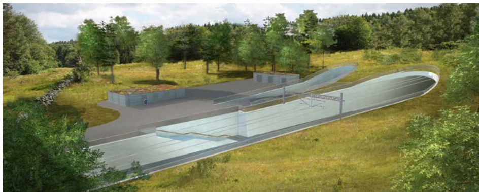
Figur 14 Principskiss över tunnels- och servicetunnelns mynning i Breared. Till vänster syns träget och strax ovanför träget syns område tänkt som uppsamlingsyta och parkering av räddningsfordon i händelse av olycka.
