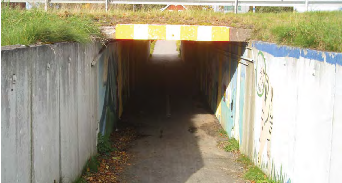
Bild 1.4.1 Befintlig cykelport under E20 i höjd med korsningen mellan E20 och väg 200.
