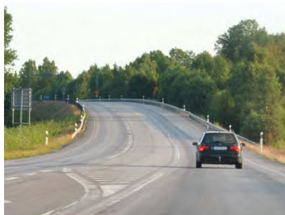
Bild 1.7.1 Bro över Kinnekullebanan, som idag inte är elektrifierad.
