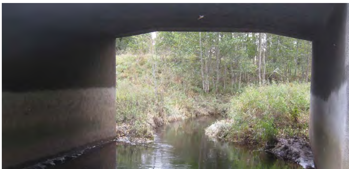
Bild 4.1.1 Hovabron med dess närmiljö som bl.a. hyser vattenfladdermöss. Till vänster ses den tidvis översvämmade faunapassagen som beskrivs under utbyggnadsförslaget och kapitel 4.2 Fauna och barriäreffekter
