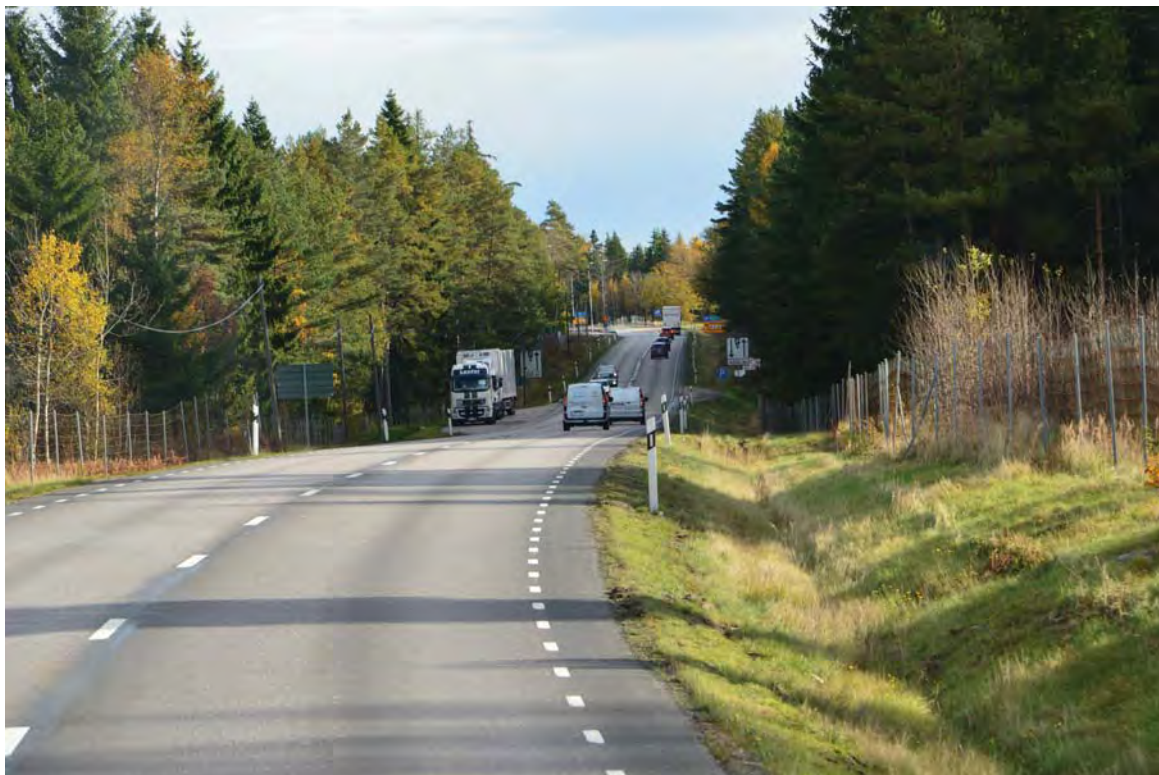
Bild 4.4.2 Befintlig väg strax söder om Bahult.
