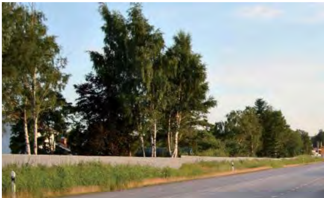
Figur 3. Vall, plank och dike vid bostäder intill E20 i Hova.
