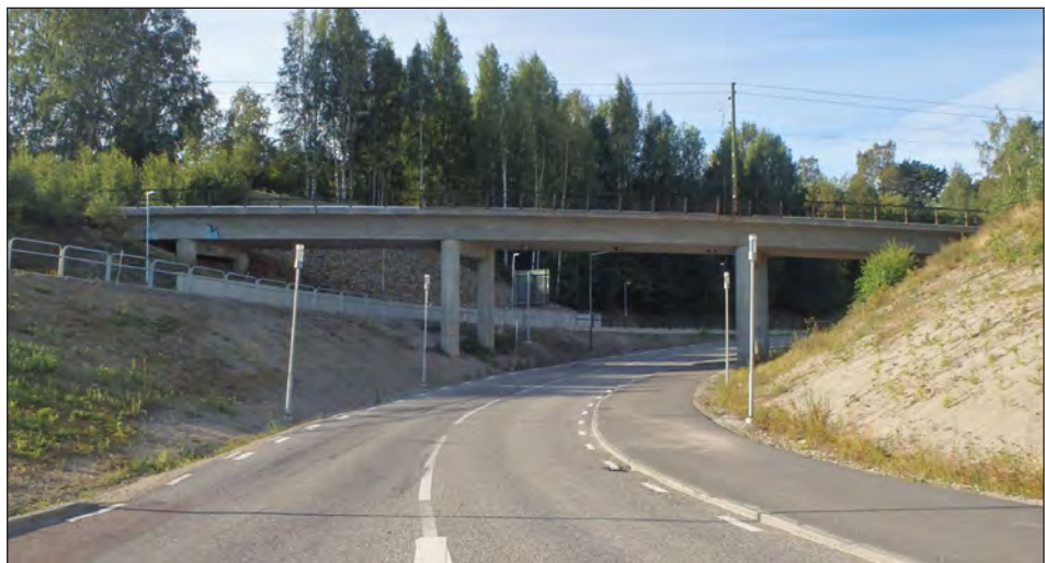
Figur 3.3:5 Bro över allmän väg Björneborgsgatan. Foto: BaTMan.
