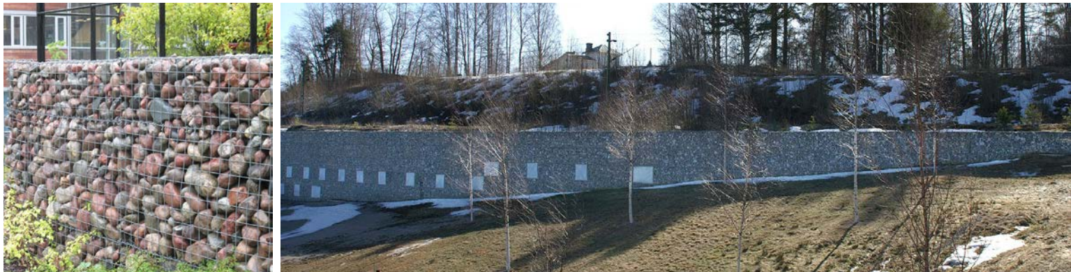
Fig. 56. Bilden till vänster visar en gabionmur som föreslås vid kyrkan och Sönderborgsgatan. Till höger befintlig stödmur vid Trafikplats Skönsmon.
