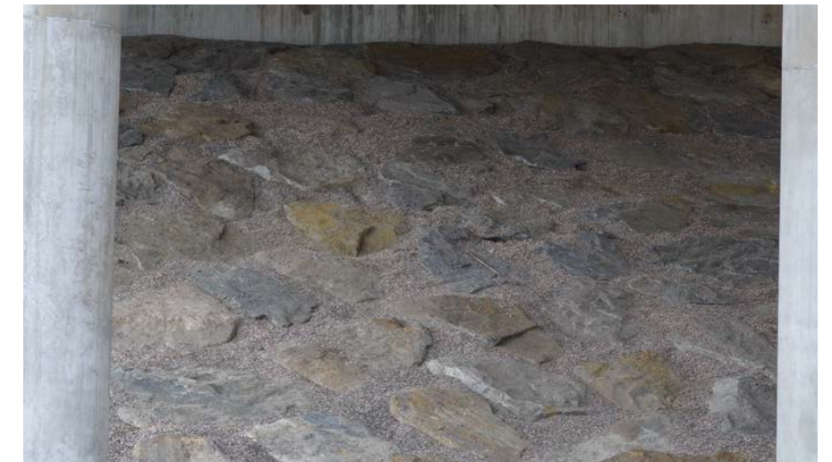
Fig. 51. Exempel på stensättning under bro.
