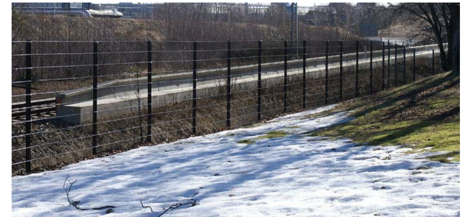
Fig. 45. Personskyddsstängsel anpassas efter befintligt i Kubikenborg.
