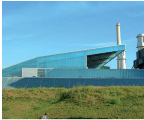
Teknikbyggnad placerad på distans från gata och trottoar. Utformad med tydlighet i form och material.
