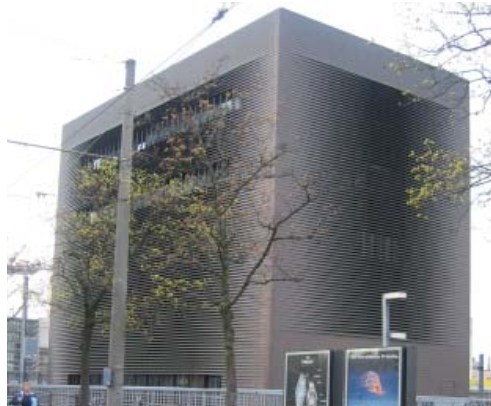
Teknikbyggnad , stor och dominant men ett positivt inslag i stadsmiljön.
