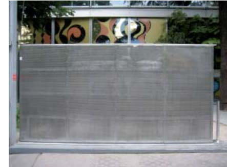
En skärmvägg av perforerad plåt ger en halvtransparent karaktär.
