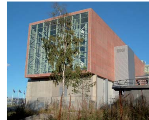
Teknikbyggnad utformad som ett tittskåp och där verksamheten blir klar avläsbar för omgivningen.
