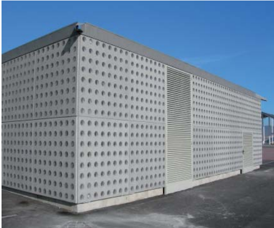
Teknikbyggnad som får ett nästan textilt intryck med sitt repetitiva mönster.
