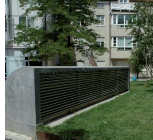
Luftintag till garage gjutet i betong med slät yta.
