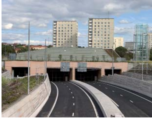
Södra Länkens frånluftsanläggning i anslutning till tunnelmynningen. Byggnaden är tät med gräsklädda kortsidor och tak och kontrasterar mot avluftstornet som är helt i glas.
