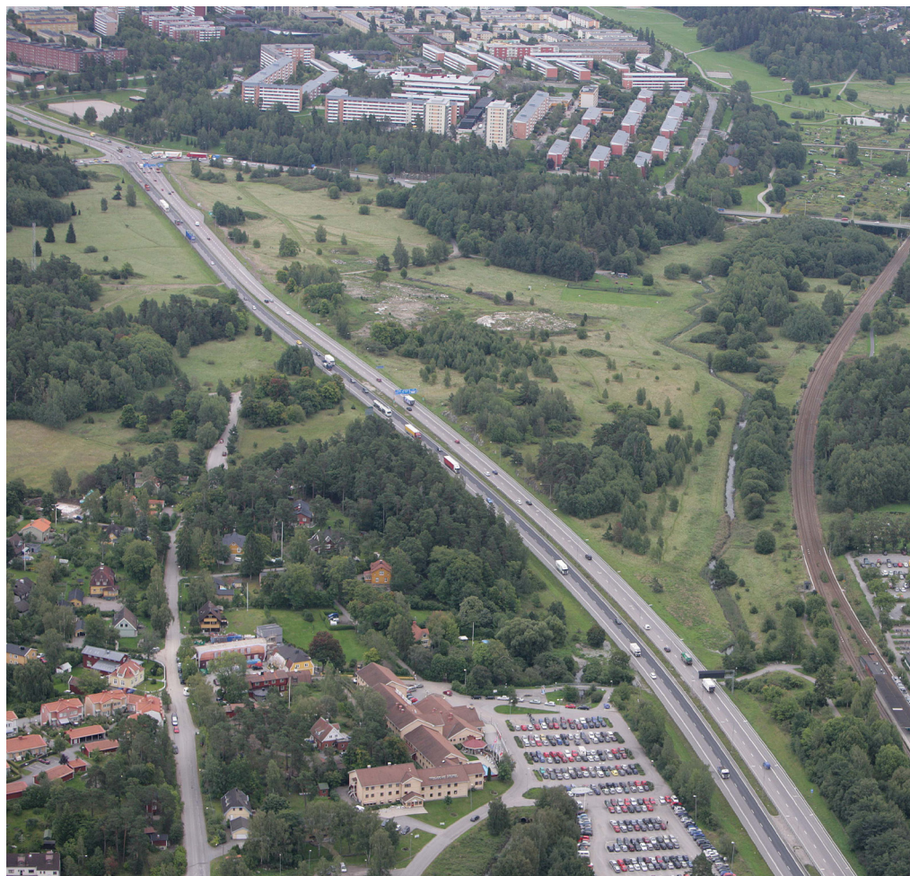
Trafikplats Hjulsta, före.
