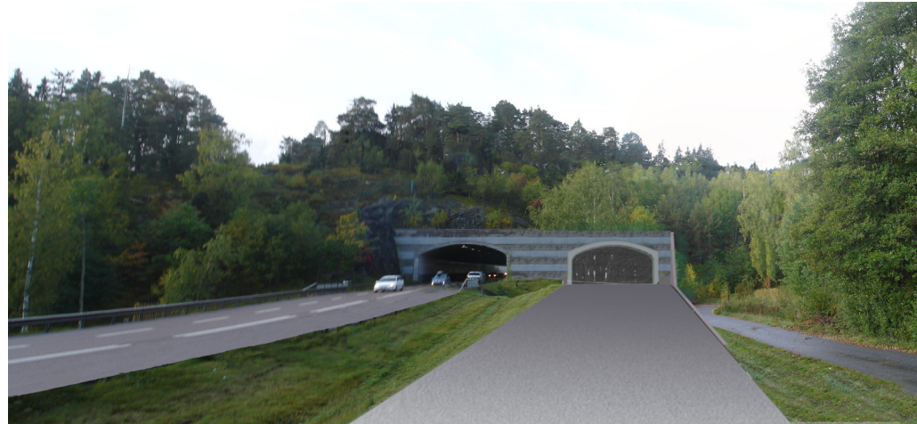
Lindötunneln, norra sidan.
