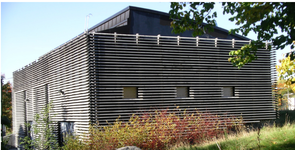
Mottagningsstation vid Södra länken.
