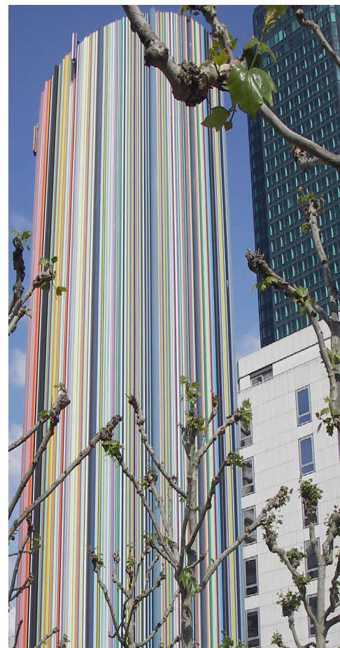
Exempel på olika ventilationstorn från Paris
