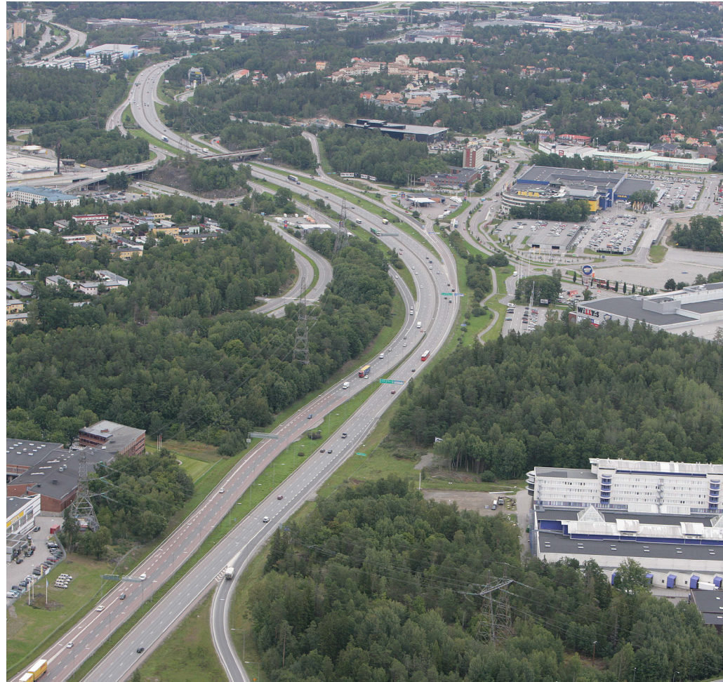
Trafikplats Kungens kurva, före.
