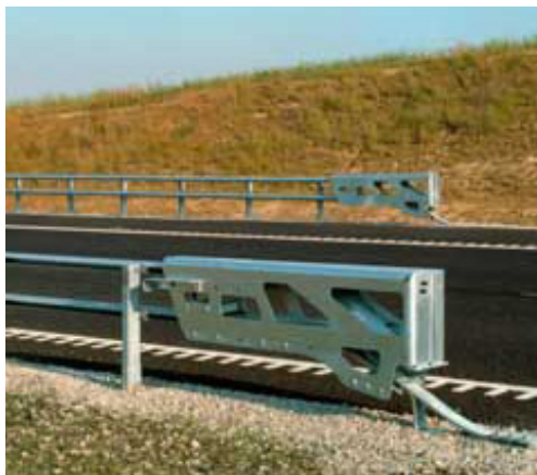
Exempel på energiabsorberande räckesavslutning för rörprofilräcke.
