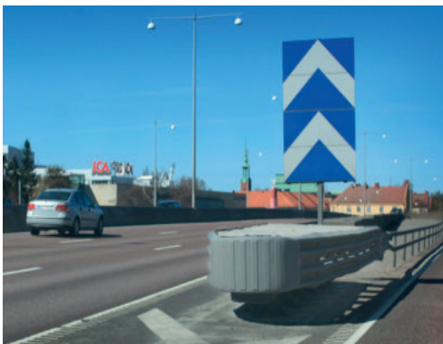
Påkörningsskydd i en rampnos. Beroende på lokalitet kan den anvisande vägskylden vara mindre.
