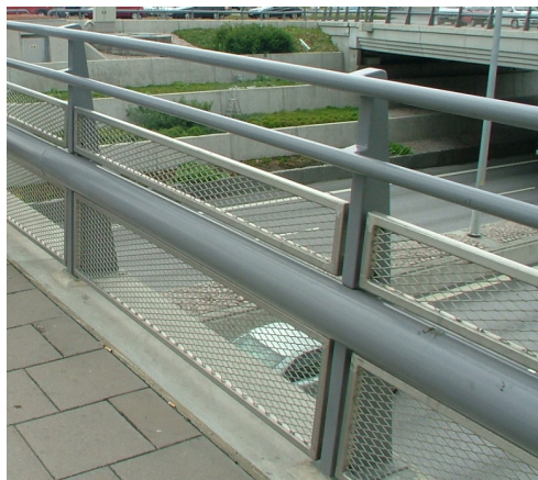
Exempel på broräcke med horisontella rörprofiler.
