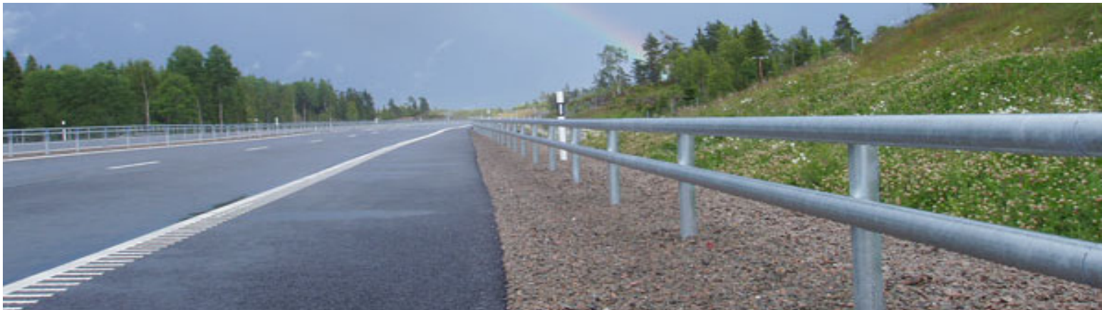
Exempel på räcke med rörprofil.
