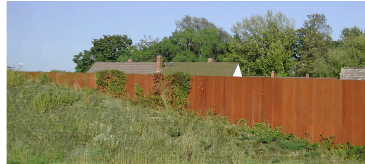
Bullerskärm av cortenstål på vall.
