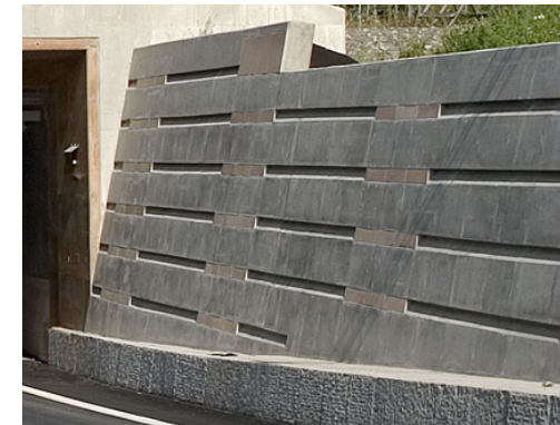
Lutande betongstödmur mot tunnelmynning, Södra länken.
