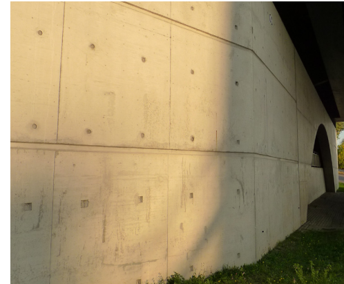
Betongyta med staghål.
