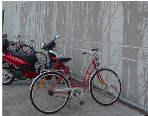
Betongstödmur med screentryck Kalmar.
