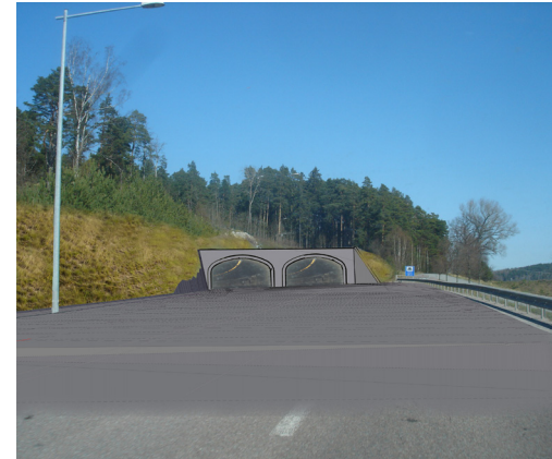
Alternativt läge för Lindötunnelns södra mynning, förlängt 50 m.
