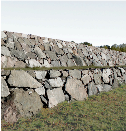
Exempel på naturstensmur, Turebergs trafikplats.
