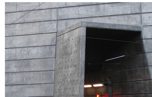
Exempel på material; bearbetad, infärgad betongyta, Göteborg.
