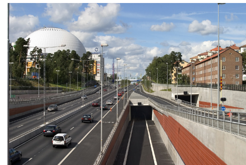
Vägens inre rum. Södra länken, vid Globen.
