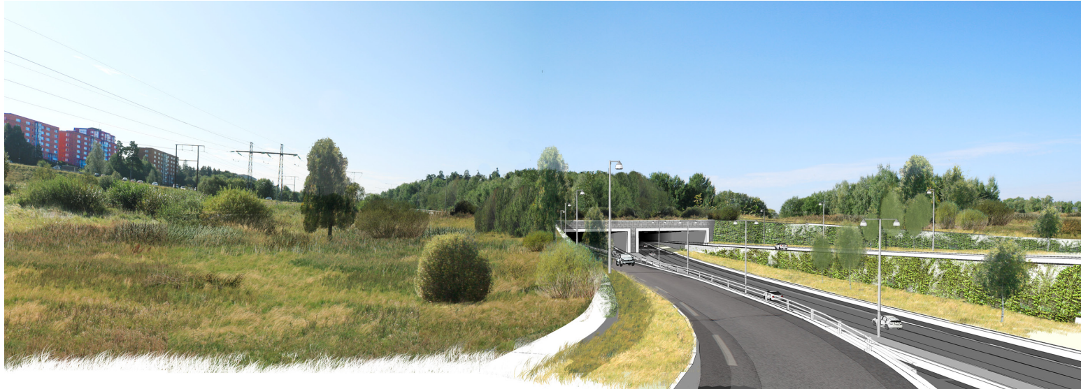
Illustration över trafikplats Akalla sett från cirkulationplatsen. Gröna trågväggar och trädgrupper utmed och i tråget hjälper till att integrera trafikplatsen i landskapet.
