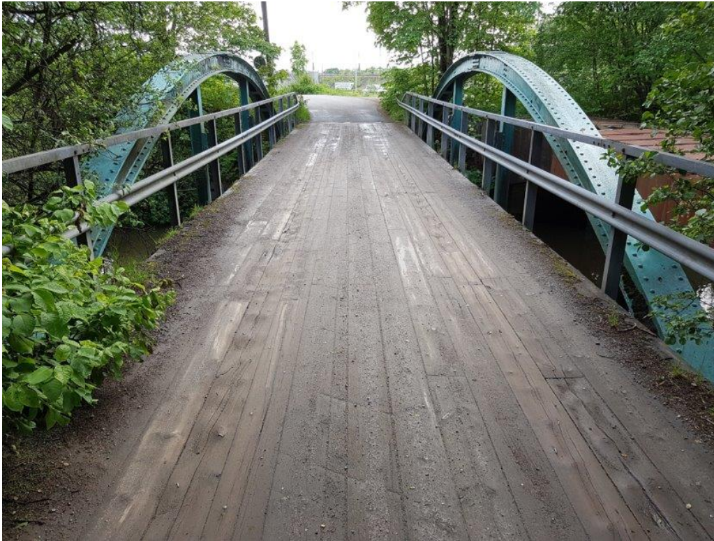
Figur 24. Befintlig bro vid Lärjeån, riktning söderut.
