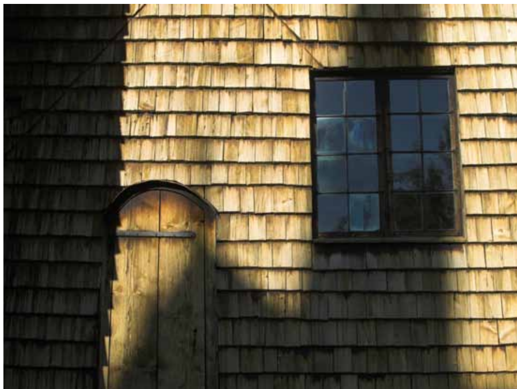
Hela fasaden på Granhults kyrka är klädd med omsorgsfullt sammanfogade spån. Kyrkan byggdes i början av 1200-talet, medan fönstren monterades på 1700-talet.
