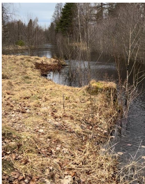
Figur 23. Damm vid Sumpen.
