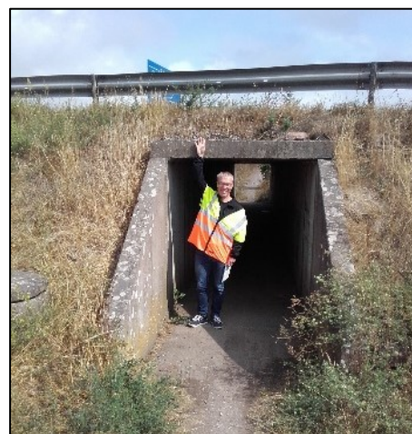
Figur 9. Gångport vid Algutsrum.
