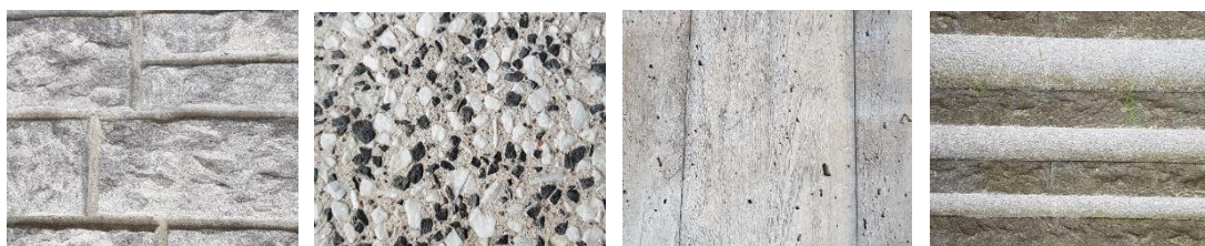
Figur 11. Material i och runt befintlig port. Matrisgjuten betong med brädform och murstensmönster, frilagd betong med sten i svart och vit färg, granittrappsteg med råkilat sättsteg och sågat plansteg.
