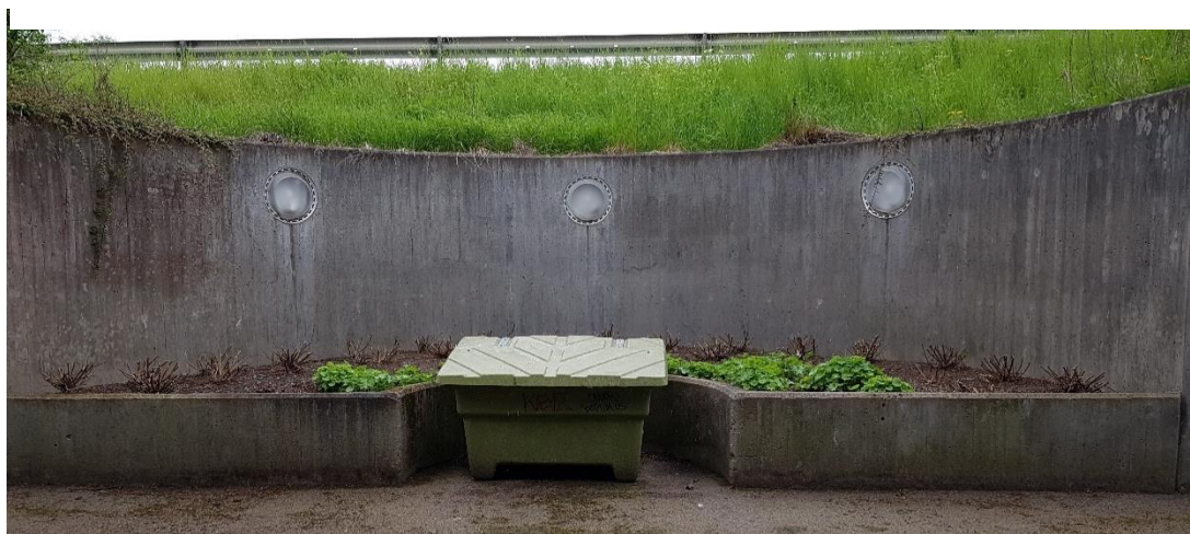
Figur 10. Platsen norr om befintlig port där den nya porten är tänkt att anläggas.
